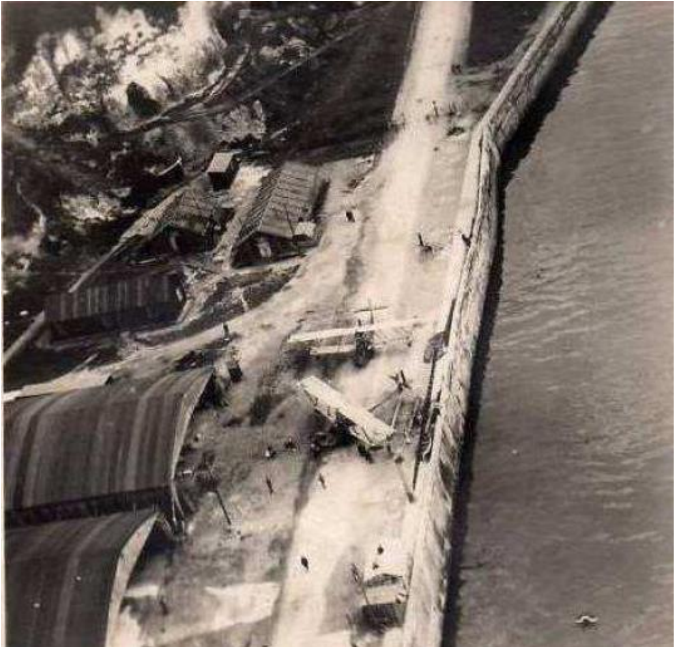
Poste de combat de Dieppe avec 2 hangars Bessonneau, 2 FBA type H et baraquements
